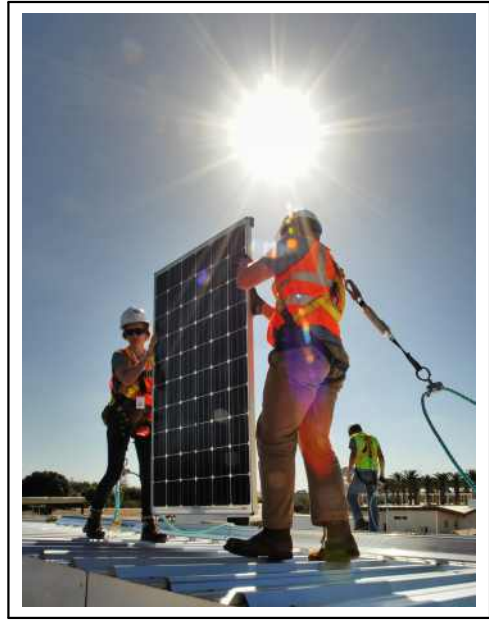
<그림 13> Solar panel의 설치 (Team CLEMSON, SD 2015)
