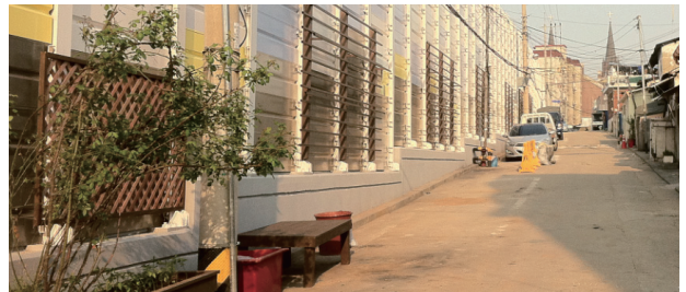
■ 방음벽 개선 후(도색작업, 다용도 프레임 등 설치)
