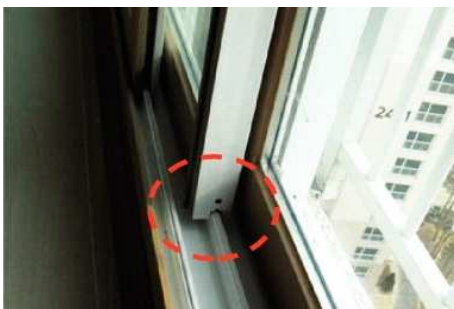
각실 PL창호 기밀유지구(풍지판) 설치 누락 또는 오설치
