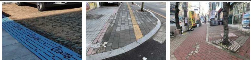
보도의 파손 및 과도한 패턴과 색상으로 조잡하고 안전을 위협하는 바닥 마감
