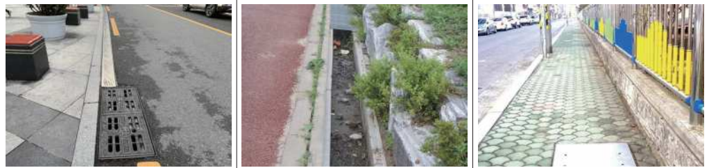
덮개가 없거나 마감이 미끄러운 재질로 설치된 배수로 덮개로 인해 보행 안전 위협
