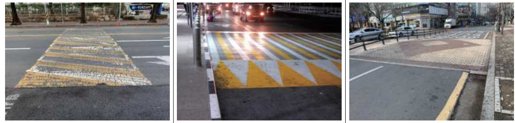
도색이 벗겨져 식별이 어렵거나 파손된 부분으로 인해 안전 보행이 어려운 경우
