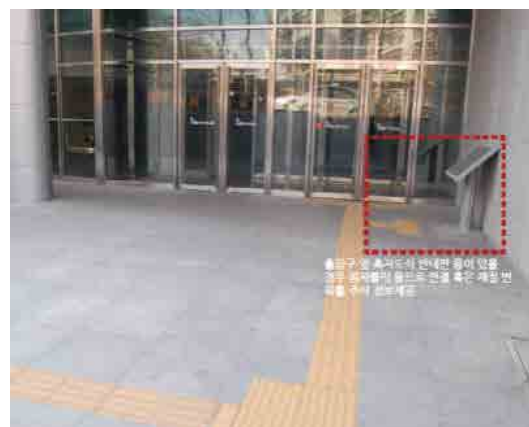
〈대지경계 - 주출입구(안내시설)의 점자블록 설치 이미지〉
