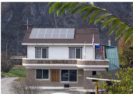
[그림 132] 충북 단양군 경로당 태양광 설치 사례
