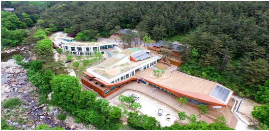
[그림 93] 지열, 태양광, 옥상녹화를 적용한 지리산생태탐방연수원
