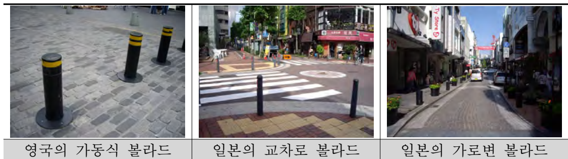
<자동차 진입 억제용 말뚝 설치 사례>
