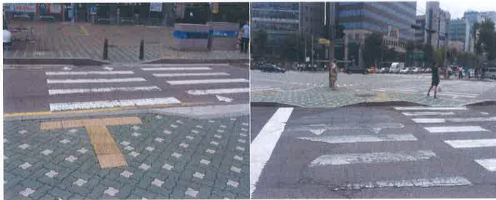
〈그림 5-24〉 교통섬 내 보도턱의 잘못된 설치 사례
