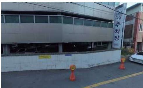
신장시장 주차장 옹벽
