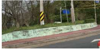
초광로 인근 옹벽
