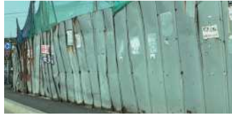
초광로 인근 공사가림막
