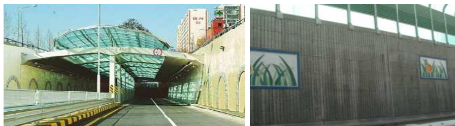
지양 : 주변과 조화성을 고려하지 않는 장식적 개념의 지하차도 상부 구조물과 거푸집
