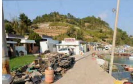
낙후된 시설 및 건축물
