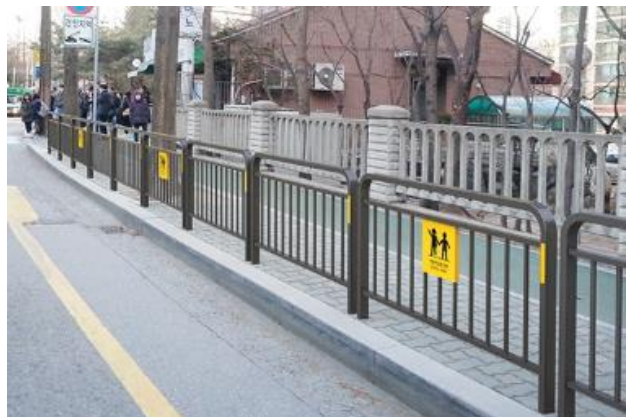
운전자가 보행자를 명확하게 인식할 수 있도록 시선의 방해를 주지 않는 펜스 설치
