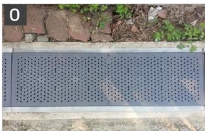
0 덮개의 표면이 보도와 동일한 높이로 설치
