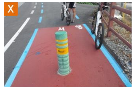
주행을 방해하는 시설물 설치
