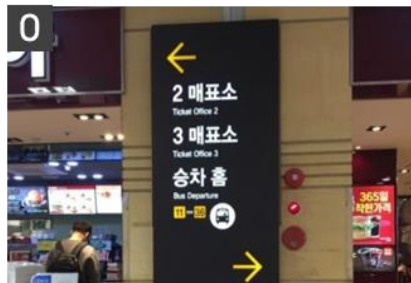
내부 조명 설치로 야간 시인성 확보
