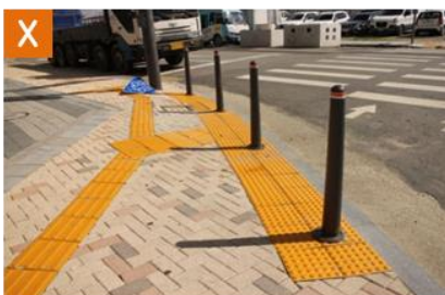
다른 시설물의 사용성을 고려하지 못한 설치
