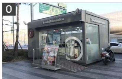
휠체어 접근을 고려한 경사로 설치
