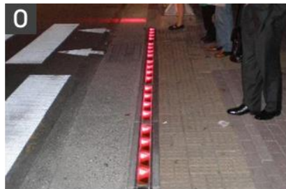
신호등과 연계된 바닥신호등으로 횡단보도 경계 표시
