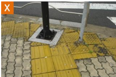
점자블록 위에 중복 설치된 시설물
