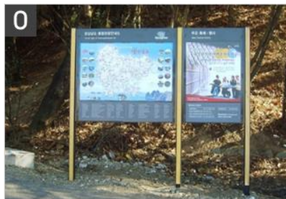
경사로에도 수평을 유지하도록 설치
