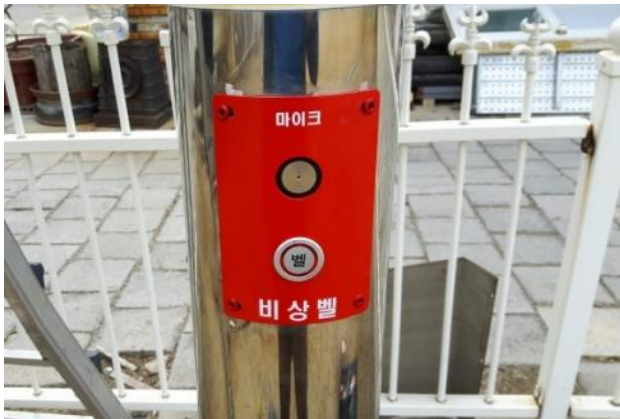
CCTV와 연계한 비상벨을 함께 설치하거나 이상음원을 감지하여 경찰에 알리는 CCTV, CCTV 안내문등을 활용
