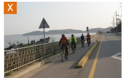
노면표지가 없는 자전거 도로
