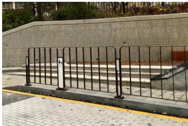
운전자가 보행자를 명확하게 인식할 수 있도록 시선의 방해를 주지 않는 펜스 설치
