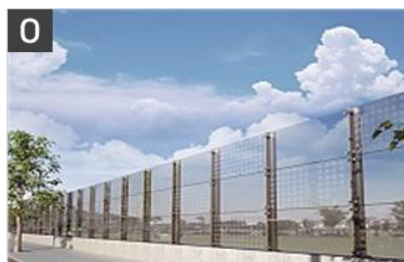
개방적 이미지의 방음벽 설치
