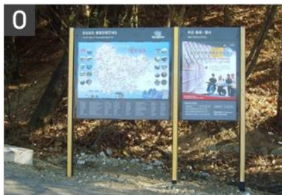
경사로에도 수평을 유지하도록 설치
