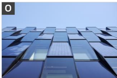
심미성 높은 에너지 절감형 입면디자인 (태양광 패널)
