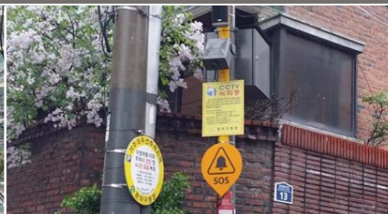
타시설물과 연계한 CCTV 설치
