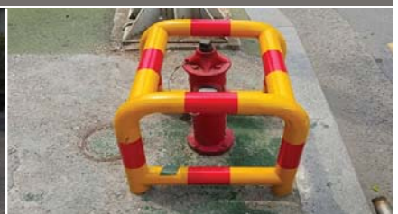
시설물 보호장치 설치
