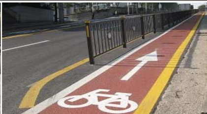
보호펜스 설치로 안전거리 확보
