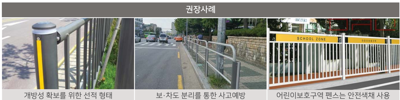
[그림 7] 보도폭에 따른 안전펜스 설치 방법
