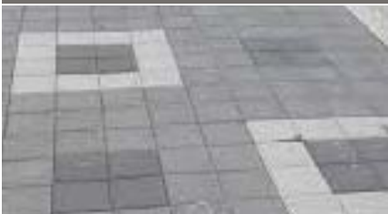
저채도의 단순한 패턴의 보도블록 설치
