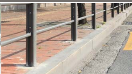
시설물 설치 시 미려한 마감처리
