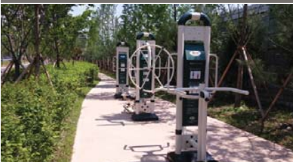
운동기구 주변 보행자 안전을 위한 식재대 설치
