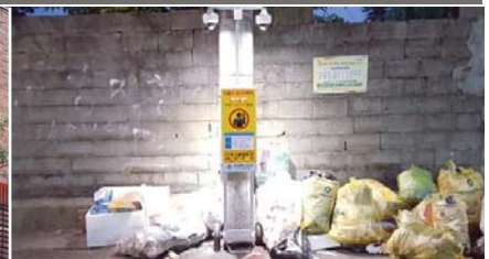
필요 공간에 따른 이동식 CCTV 설치
