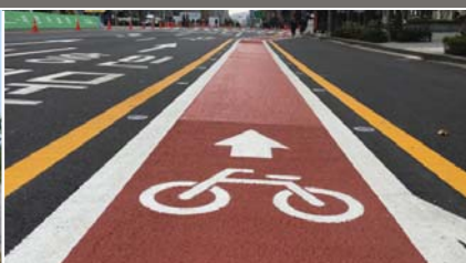
도로 및 보행도로와 분리된 색채계획
