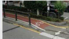
보도 또는 차도의 일부공간 활용 일반차량이 침범할 수 없도록 보도와 같은 높이로 설치한 도로
