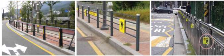
대형트럭차량 주행을 고려한 보차로 구분 및 안전펜스 설치
