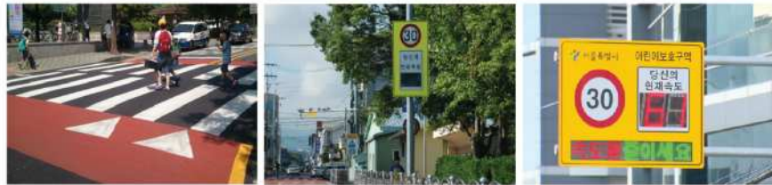
차량속도저감 시설 설치로 안전운전 유도
