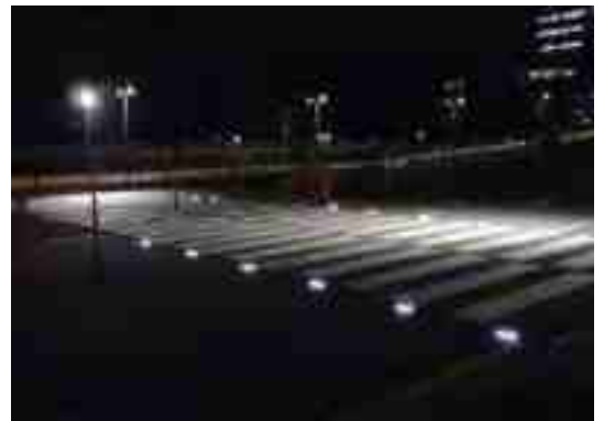
횡단보도 조명 B
