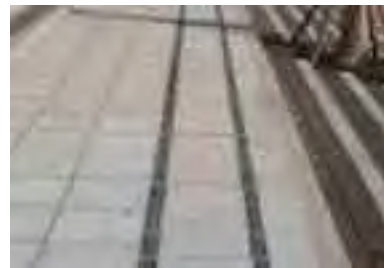
③ 배수로 평탄하게 마감
