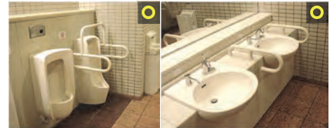
[그림 5-205 유니버설디자인 개념이 도입된 화장실 내부 예시]
