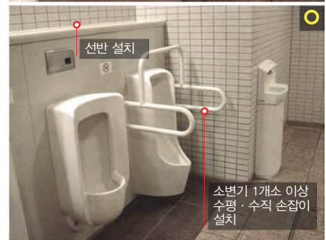
[그림 5-190 세면대, 소변기 손잡이 설치 예시]
