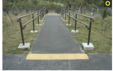
[그림 5-215 점자블록 및 핸드레일 설치 사례]
