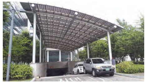
[ 그림 5-159 주차공간 상부 태양광집열판 설치 사례 ]
