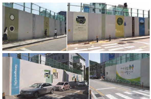
[ 그림 5-34 공사장가림막 및 안내표지판 적용 예시 ]
