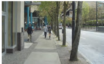
▲ 색채·재료를 통일시켜 확장성을 강조한 바닥 포장
