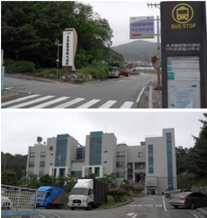
차량위주의 동선 구성으로 보행자의 접근성 결여 보행가로 등 공공 공간과의 연계성 부족
