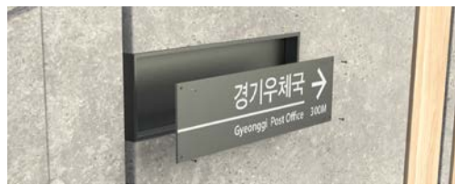
안내사인 결합 : 스테인리스 스틸 (도장, 건식시공)
