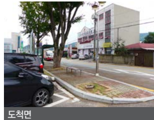
도척면 보행로를 가로막는 위치에 설치된 벤치
