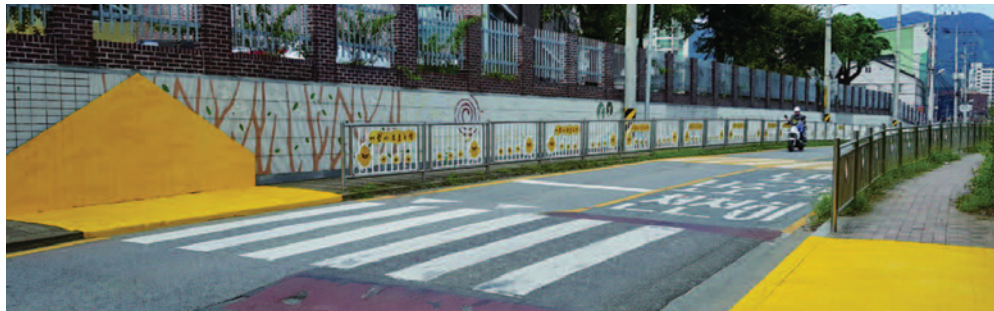
횡단보도 앞 옐로카펫 구역 설정 및 안전펜스 설치
