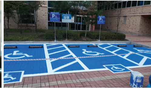
건축물과 가깝게 설치된 장애인 주차구역
