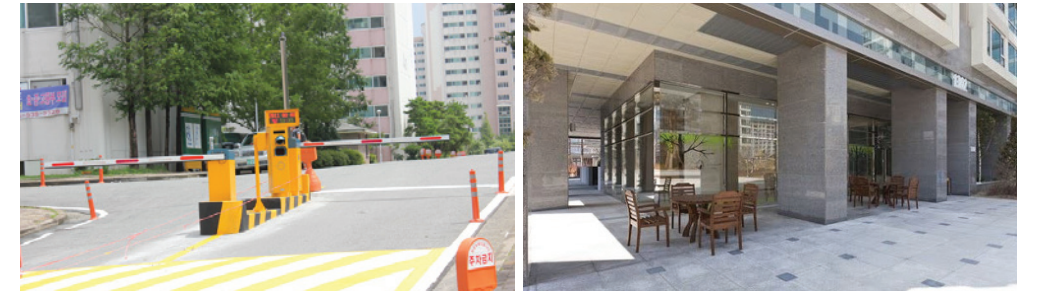
단지 출입구에 차량 출입 차단기 설치
