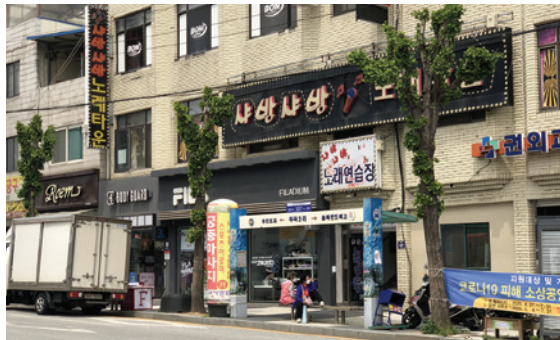
도로와의 이격거리 없이 노출된 버스정류장
