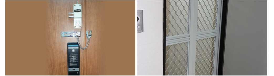
디지털도어록, 보조키, 도어체인 동시 설치
