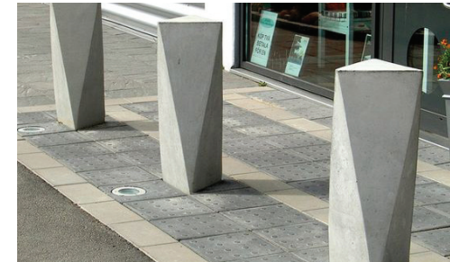
볼라드 주변의 점자블록 설치
