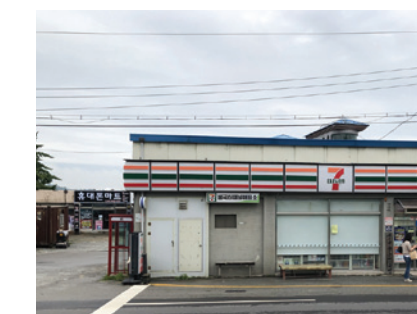
이용자 대기공간 부재 및 터미널안내 인지도 부족(생극터미널매표소)
