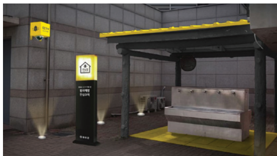
시야 사각지대 방법용 CCTV 및 조명설치
