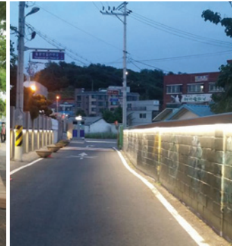
골목길 조명 설치
