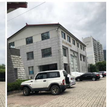
장애인 주차장 부재
