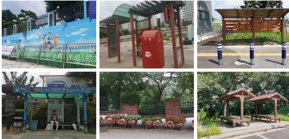
이용자 기준의 설치 기준이 미흡
