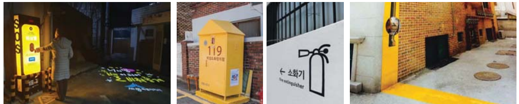
CCTV, 비상벨, 소화기함, 고보조명, 반사경 등 안전재난시설물 설치
