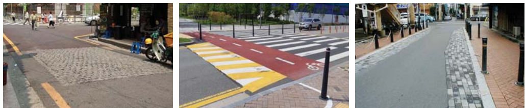
차량 속도 저감을 위한 시설 설치 또는 도로 선형 변경(시케인, 도로다이아트 개념)
