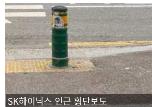
SK하이닉스 인근 횡단보도 시설 관리미흡으로 인한 파손 및 교통약자를 배려하지 않은 설치계획
