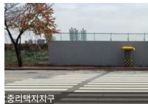
중리택지지구 심미성을 고려하지 않은 임시시설물 외벽
