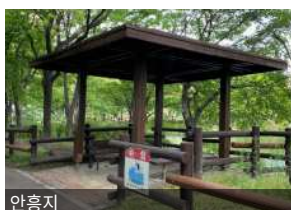
안흥지 조명시설 미설치
