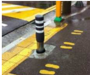
· 세로형 펜스 및 볼라드 설치
