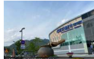
신둔도예촌역 앞 광장 휴게시설이 부족하고 그늘진 공간이 부족
