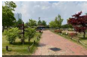
북하천 수변공원(중리동) 시설물 파손으로 보행 안전성과 진입부 쾌적성 저하
