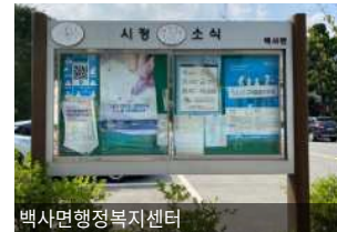
백사면행정복지센터 빛 반사로 인해 이용자를 배려하지 않은 디자인, 시설 노후화, 관리미흡
