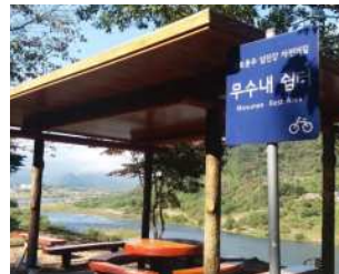
· 파고라 등 휴게시설 설치 및 쉼터 조성
