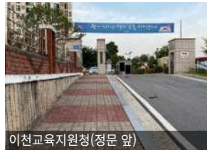
이천교육지원청(정문 앞) 차도와 보도가 구분되어 있는 주출입구
