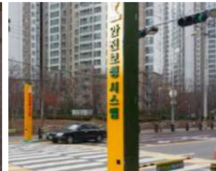
· 횡단보도 보행자 보호시설 설치
