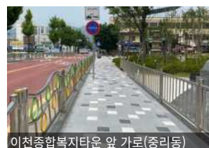
이천중합복지타운 앞 가로(중리동) 동일 가로 내 여러가지 형태의 펜스 설치
