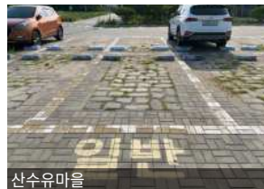
산수유마을 주차장 바닥노면표시 표준에 부적합
