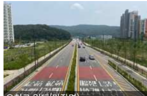
오천교 일대(마장면) 녹지를 활용한 중앙분리대 조성
