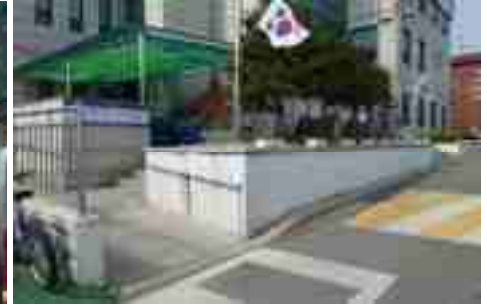
▲ 가로공간 및 주차공간 등에서의 접근성 미흡
