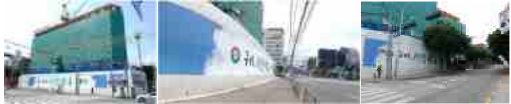
〈그림 5-20 고층단독건축물 가설울타리 등 설치 현황〉
