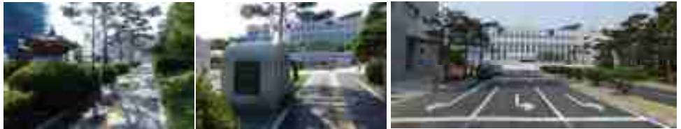
▲ 주출입구간 경사지에 위치하여 인근 도로에서의 인지가 미흡한 시점 (개선사업 전)
