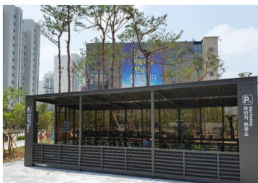
〈휴게시설 주변 자전거 보관소 설치〉
