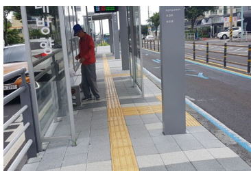
〈시설물을 고려한 유도블록 설치〉
