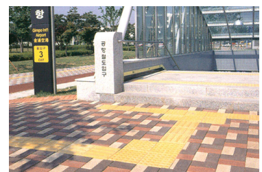
〈높낮이 변화에 따른 블록 설치〉
