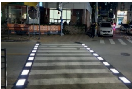
스마트 횡단보도 설치
