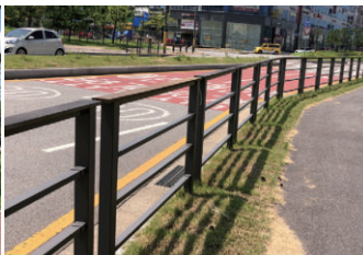
▲ 가로변 안전펜스와 띠녹지
