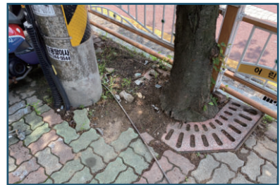
▲ 파손된 보도블럭과 가로수보호대
