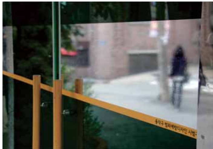
출입문 반사시트 설치
