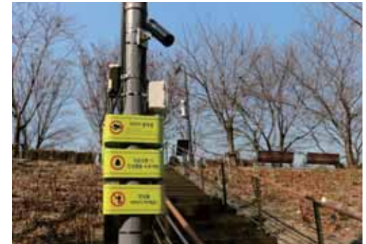
안심 비상벨 설치
