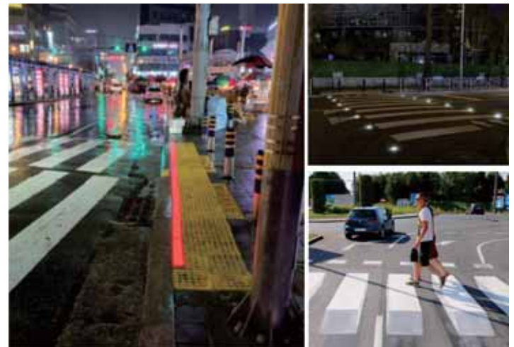
횡단보도 안전 유도시설 설치
