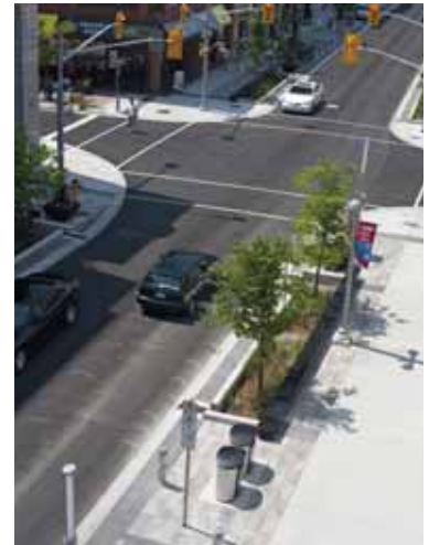
▲ 가로시설물 통합 설치
