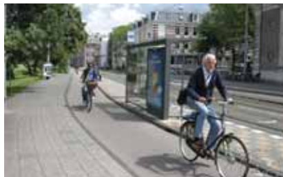
▲ 자전거 도로 정비 : 보행로와 연계하여 설치한 경우
