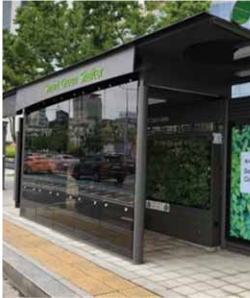
▲ 미세먼지 저감 시설물 설치
