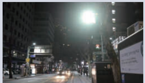
(O) 스마트 가로등 설치
