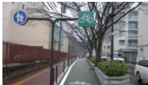
(O) 자전거도로 안전표지판 설치
