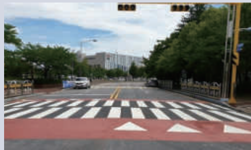
(O) 고원식 횡단보도 설치
