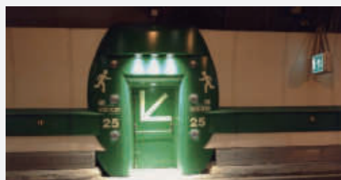
(O) 터널 내부 비상탈출구
