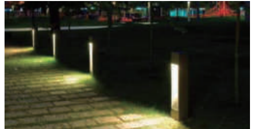
(O) 보행 안전을 고려한 조명기구 설치
