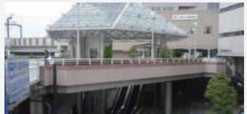
(O) 교통약자를 배려한 승강기 설치
