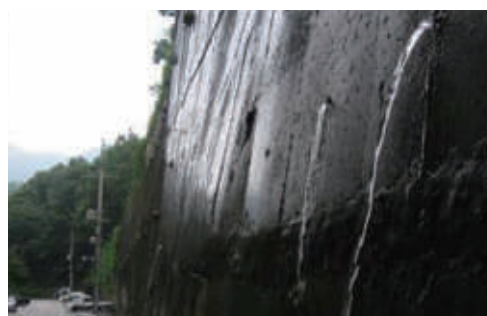
(O) 유출수 흔적을 방지하는 내림각 설치
