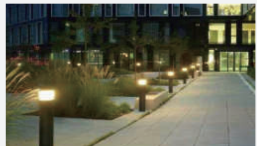
(O) 보행에 방해가 되지 않는 설치
