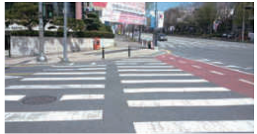
(X) 횡단보도 내 맨홀 설치
