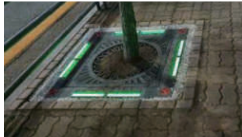
(O) 가로수보호대 간접조명 설치
