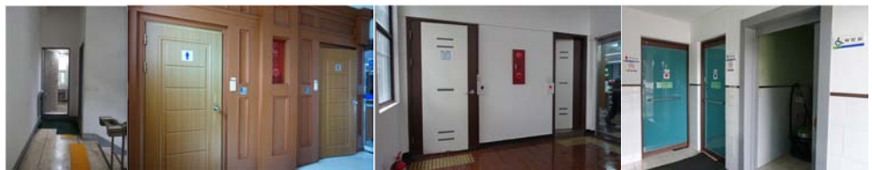
▲ 읍·면사무소의 화장실 출입문 현황
