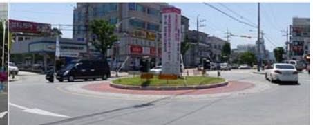
▲ 양평시의외버스터미널 인근 회전교차로 현황
