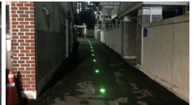
바닥 조명등 설치
