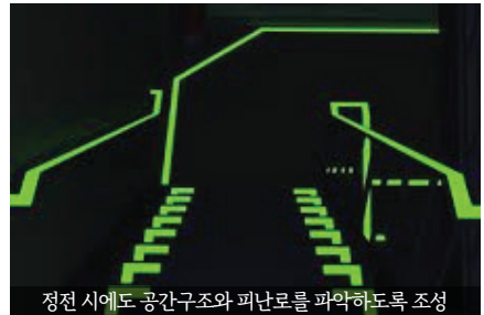
정전 시에도 공간구조와 피난로를 파악하도록 조성
