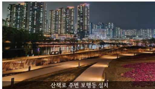
산책로 주변 보행등 설치
