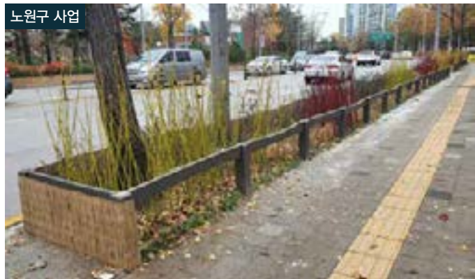
▲ 가로녹지변 피복지 조성 및 기존 철재펜스를 대체한 목책설치(노원로 노해근린공원 인근)
