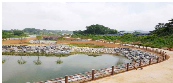
비점오염저감시설 (충청남도 서산시)
