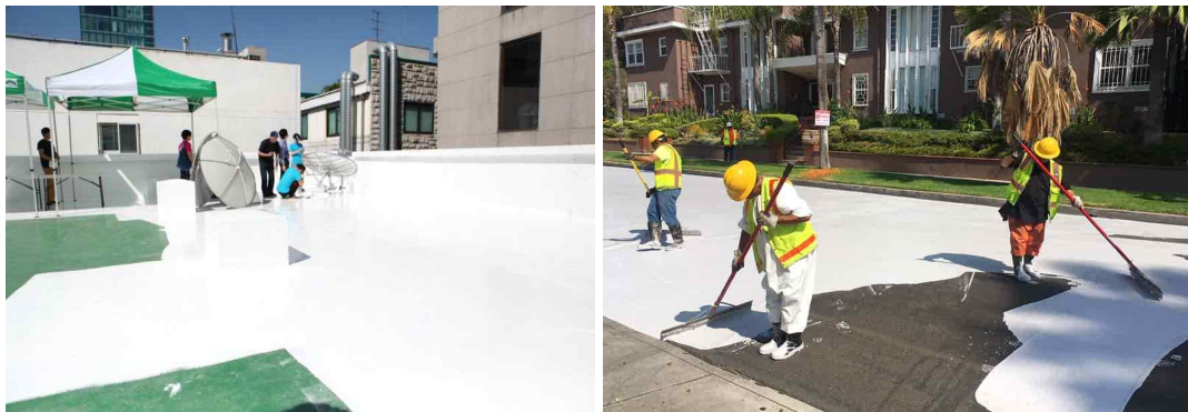
[그림 6.60] 쿨 루프(좌) 및 쿨 페이브먼트(우) 시공사례
