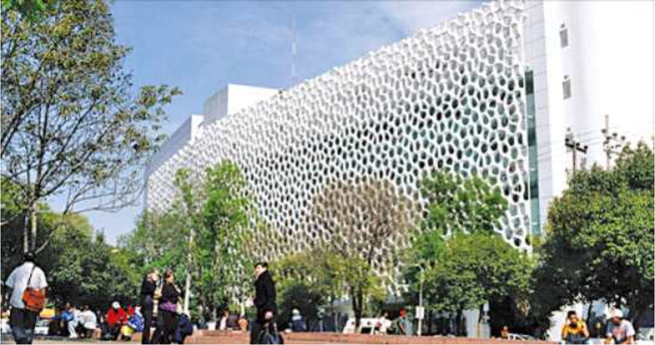
[그림 5-7] 멕시코 공해 먹는 빌딩 곤살레스병원 건물
