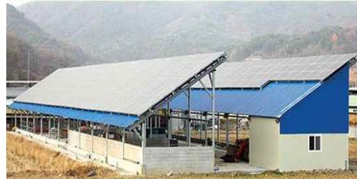
[그림 186] 축사 태양광 발전 설치 사례
