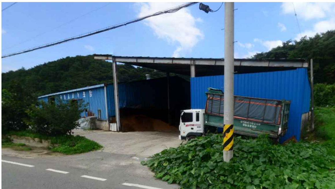
[그림 II-5-2] 산청군 신안면 가축분뇨 퇴비화 위탁시설(개인시설)
