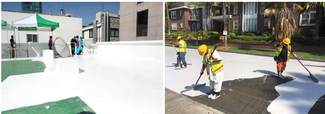
[그림 6-93] 쿨루프(좌) 및 쿨 페이브먼트(우) 시공사례
