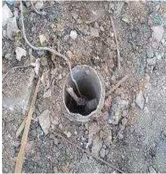
❶ 모터펌프 및 보호시설이 없는 경우
