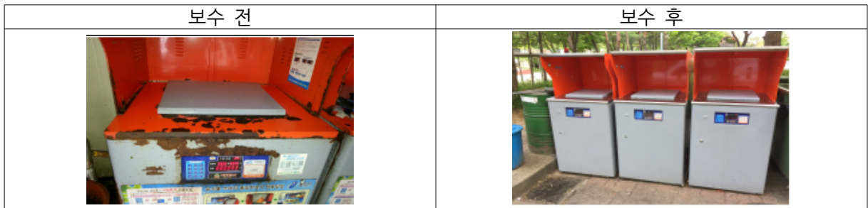
[그림 1-18] 음식물류 폐기물 종량제기(RFID) 보수 및 도색 실시
