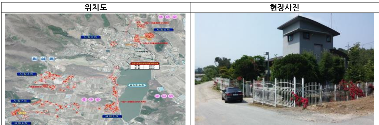
[그림 1-17] 사전 소규모공공하수처리시설 증설
