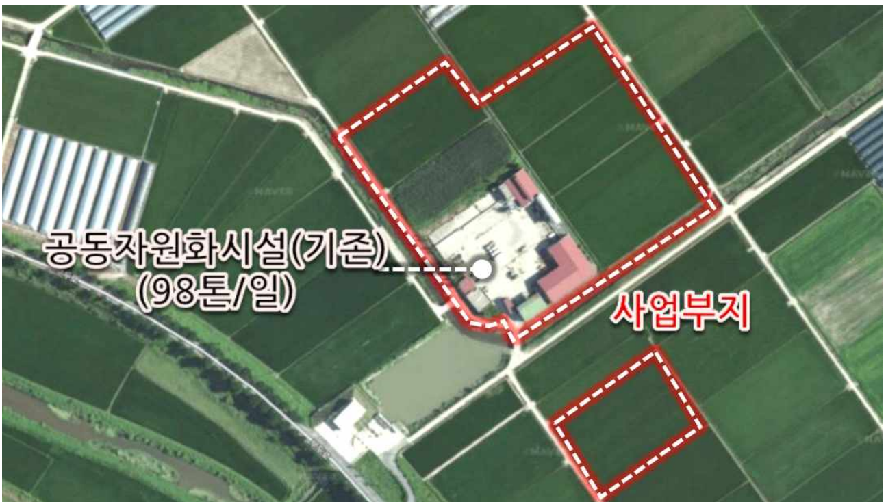
그림 6-8. 부여군 통합 바이오가스화시설 부지(자료 : 부여군 내부자료)
