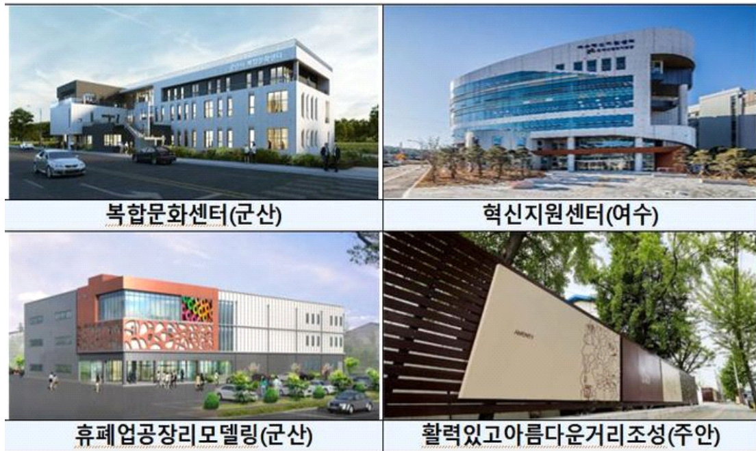
그림 32. 휴·폐업공장 리모델링 관련 사진
