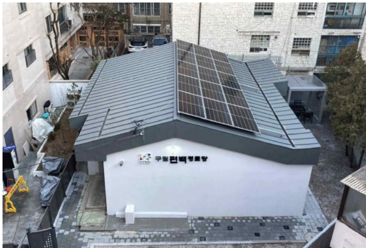
[그림 부1-7] 노원구 편백 경로당 단열보강 및 태양광 설치
