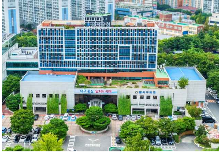
그림 6-9. 달서구청사 외벽리모델링 공사
