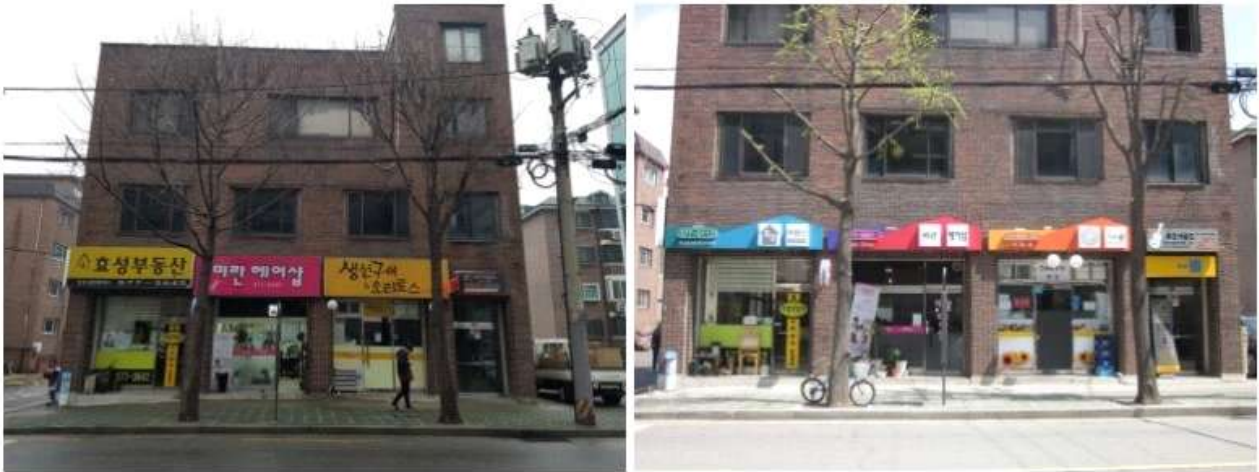
〈그림 6-1〉 상가 LED간판 교체사업 추진 전·후
