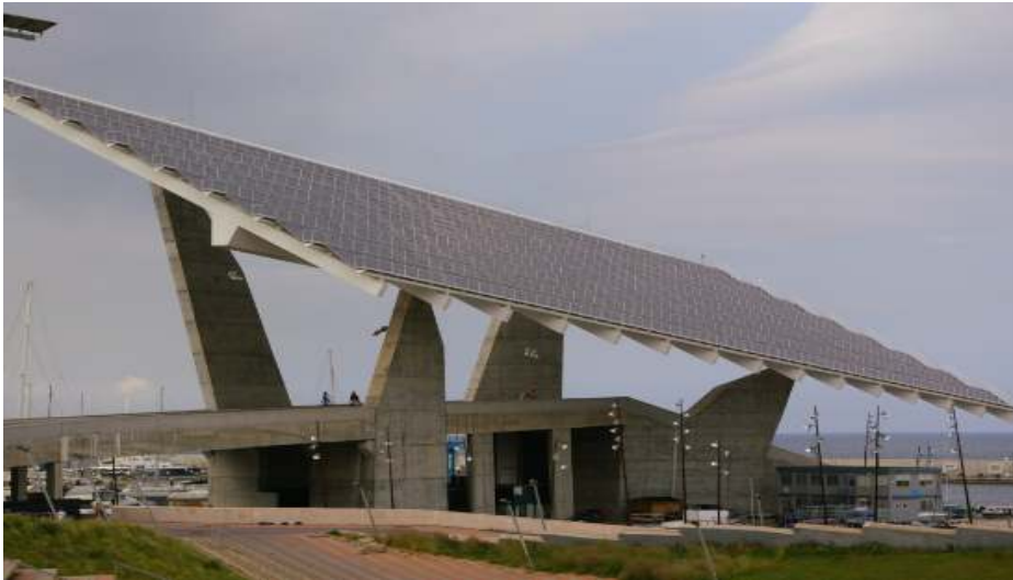
〈그림 29〉 요트항인 포트 포룸에 설치된 초대형 태양광 패널
