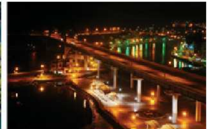
통영대교(야간) (통영시 미수해안로)
