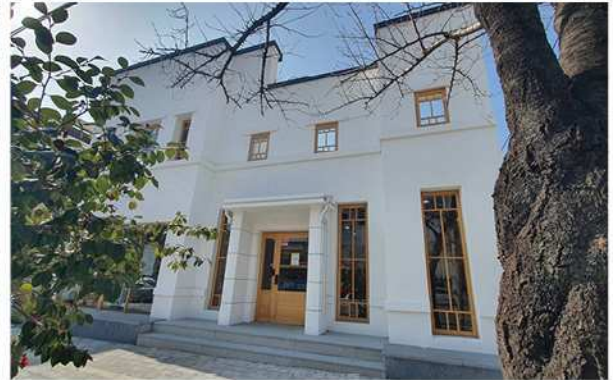
[ 노후상가를 리모델링한 공동이용시설(보태가) ]
