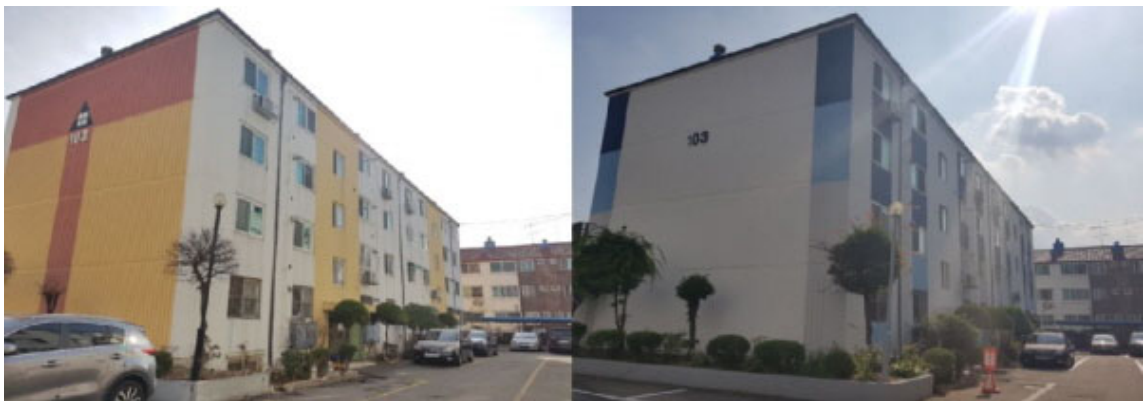
그림 5-3 노후 소규모 공동주택 지원사업 예시(외벽 및 도로포장)
