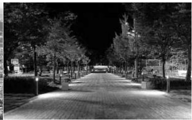
공원 내 조명 안전시설 설치 [예시]
