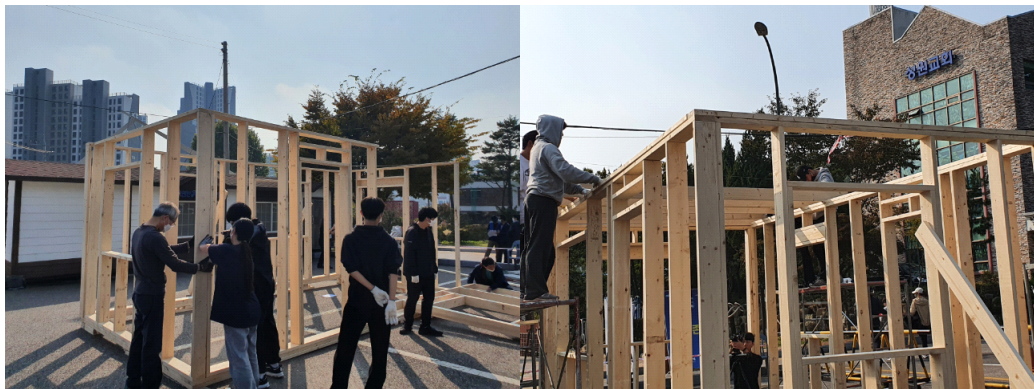
(1일차) 벽체 및 지붕골조 공사
