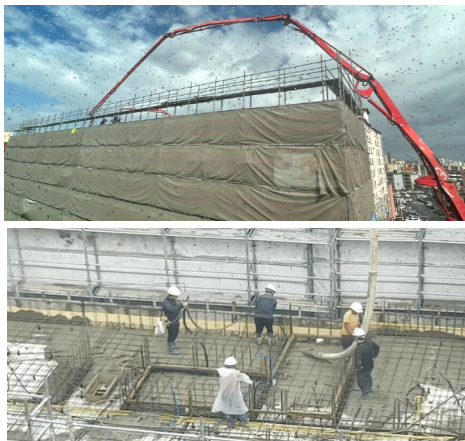
[그림 V-18] 제주시 연동 한 오피스텔 신축현장 (2023년 7월 우천중 콘크리트 타설) ( http://www.jejuori.net/news/articleView.html?idxno=417297 )
