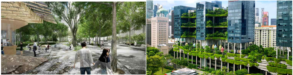
【그림 3-1】 서울 도심 내 개방형녹지(다동공원) 예시와 싱가포르 건축물 입체녹화 사례
