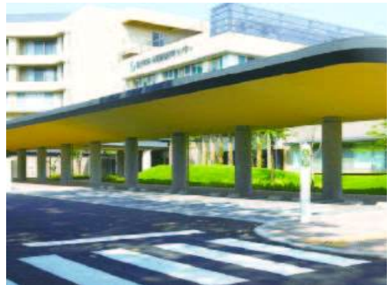
주차구역 상부에 눈, 비로부터 보호되는 지붕 설치
