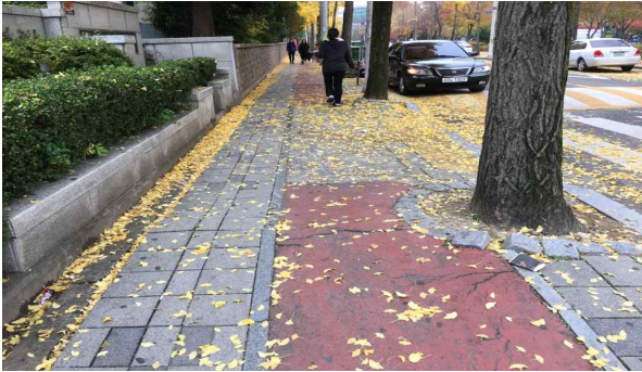
가로 시설물 등에 의해 끊겨 있거나, 보도의 폭이 좁아 자전거 통행에 문제 발생
