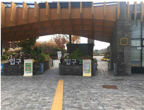
시각장애인을 위한 점자블록 설치 및 평탄한 동선 조성
