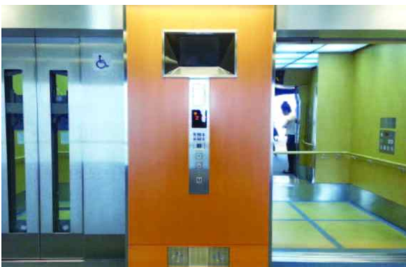
투시창 설치, 발로 누를 수 있는 엘리베이터 버튼, 후면 관찰용 전면 거울과 시·청각 안내 설치
