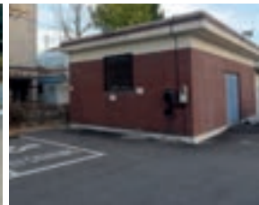
▲ 이용하기에 불편한 위치에 무분별하게 설치된 충전기
