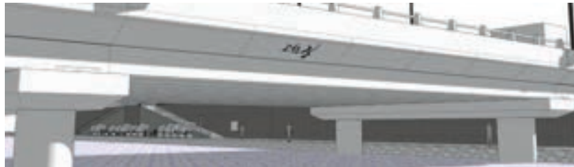
▲ 교량 하부 측면에 교량 명칭 적용
