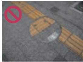
▲ 방향이 어긋난 맨홀 뚜껑의 점자블록
