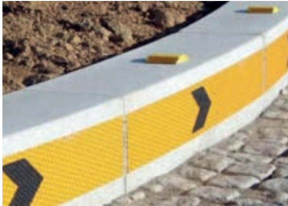
▲ 경계석 측면의 시선유도 시트와 상단의 표지병
