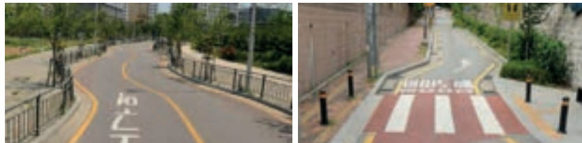
▲ 지그재그 형태의 도로 설치 사례 (좌: 슬라롬(Slalom) 형, 우: 크랭크(Crank) 형)
