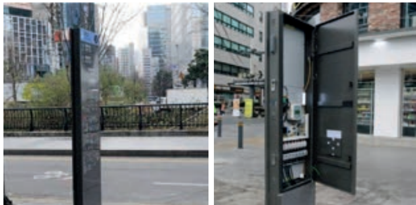
▲ 보행방향에 마주하게 설치
