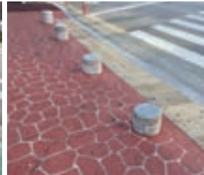
▲ 시각장애인 등에게 위험한 낮은 석재 볼라드
