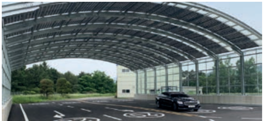
▲ 천장부에 적용한 태양광 패널 방음벽
