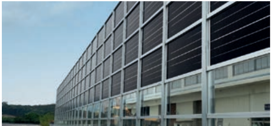
▲ 상단부에 적용한 태양광 패널 방음벽
