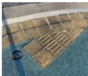
▲ 설치 규정을 준수하지 않은 점자블록
