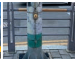
▲ 이용하기 불편한 위치와 시인성이 낮은 비상벨
