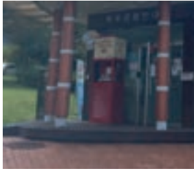
▲턱낮춤이 미비한 출입구
