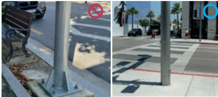
▲ 지주 시설물의 기초구조 매립
