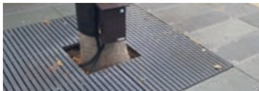
▲ 가로수 보호덮개, 보도블록, 점자블록이 동일한 높이로 시공된 사례
