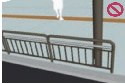
▲ 시설물과 중첩되게 설치
