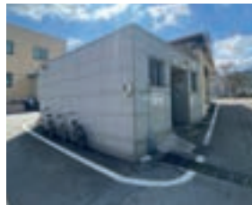
▲시인성이 부족한 화장실 안내표지
