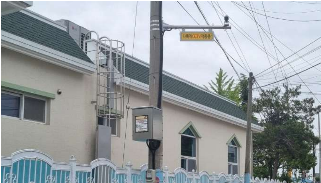
출처 : 뉴스핌, 정선군, 다목적 CCTV 설치 확대 운영...사각지대 해소
